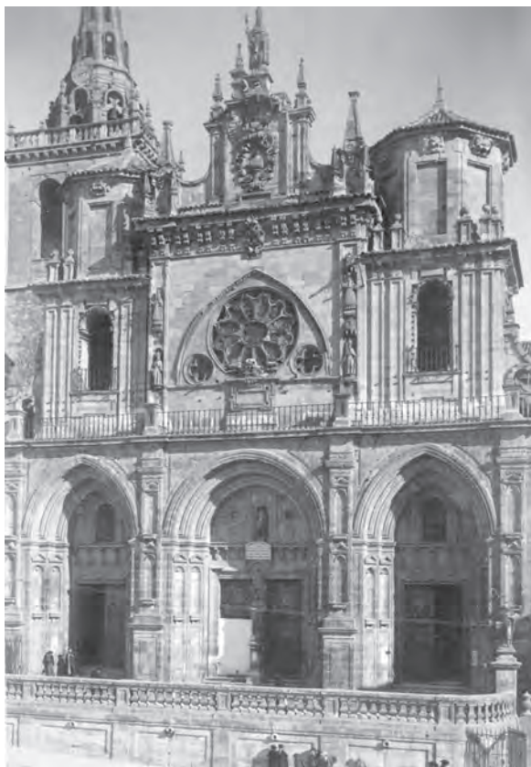
Fachada destruida de la catedral de Cuenca
